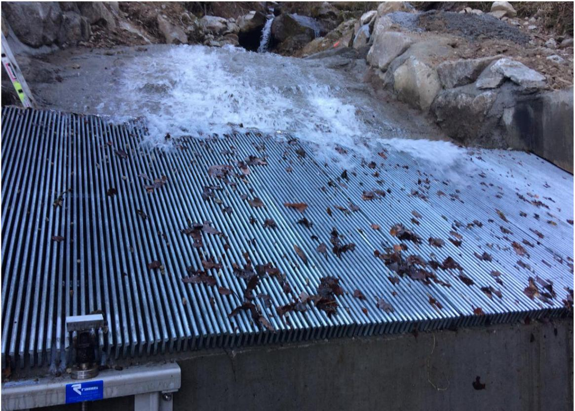
Figure 6 : Exemple de profilé rond-carré sur une prise tyrolienne avec espacement de 10 mm
