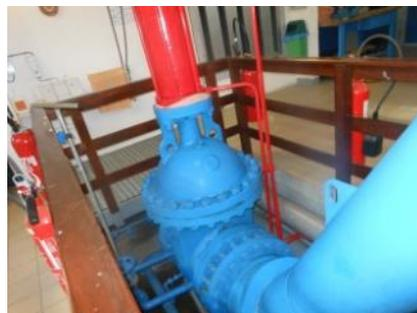
La vanne de pied, de type vanne-section, est utilisée manuellement pour les travaux sur la turbine et les injecteurs.
