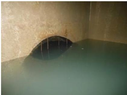
Les eaux sont dirigées vers la chambre de mise en charge par un déversoir frontal simple. Deux grilles grossières anti-intrusion sont disposées au niveau du déversoir et au niveau de l'entonnement. Le départ vers la conduite forcée se fait via un convergent DN1400-DN800. La cote de régulation est fixée à 1299,5 m NGF.
