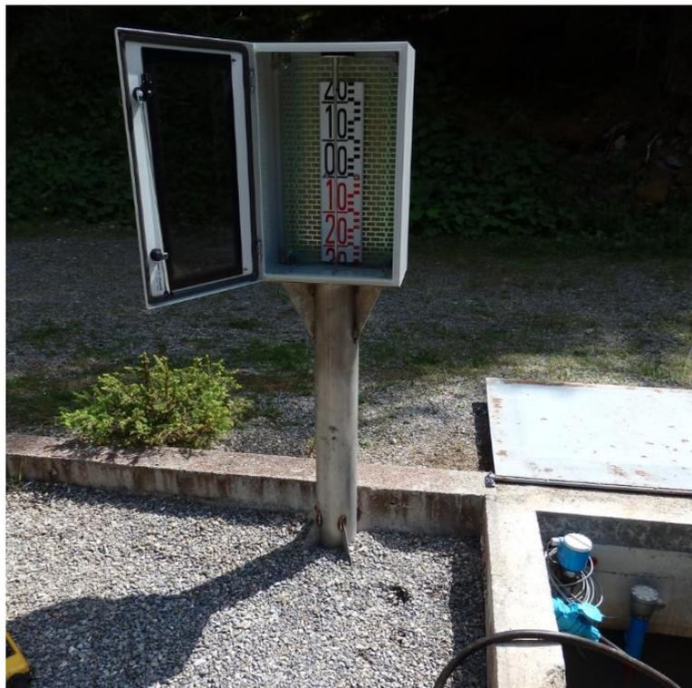
Figure 12 : Système limnimétrique déporté permettant un accès rapide au niveau d'eau dans le dessableur pour la vérification du débit réservé
