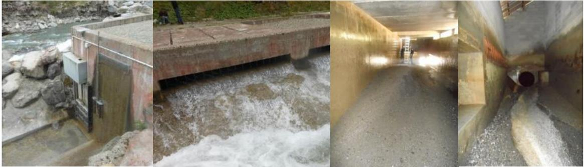
Figure 8 : vanne de chasse et digue de protection
